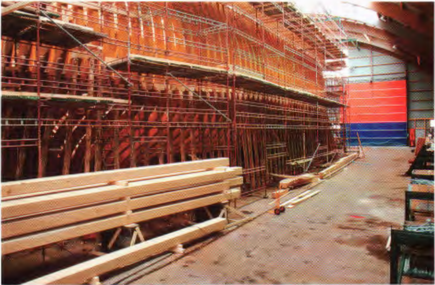
Det var fascinerande att se Götheborg III växa fram. Skrovet byggs i ca 75 % ek och 25 % fur.
